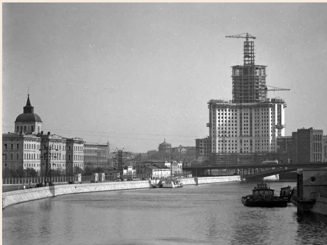
Строительство высотного здания на Котельнической набережной, 1948
