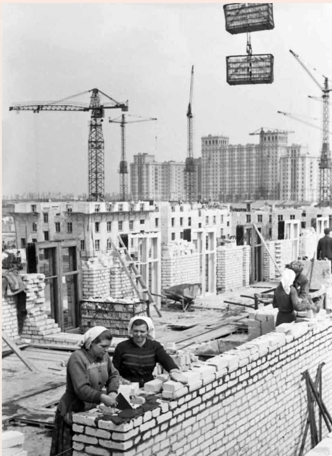
Строительство жилого дома на юго-западе Москвы, 1955
