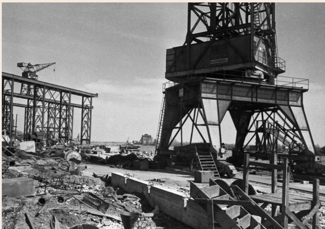
Строительство промышленного объекта, 1945
