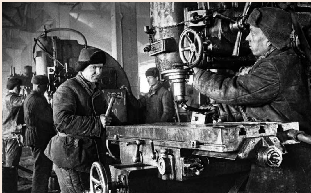
Рабочие во время ремонта оборудования, г. Сталинград, 1943
